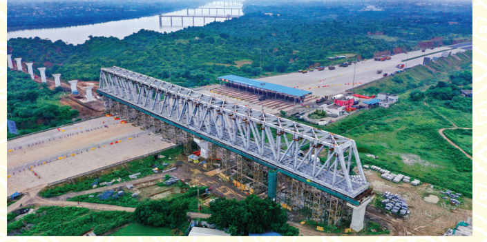
वडोदराजवळ दिल्ली-मुंबई राष्ट्रीय द्रुतगती महामार्गावर २३० मीटर लांबीचा 'मेक इन इंडिया' स्टील पूल
